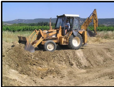
Creusement mécanique du bassin
