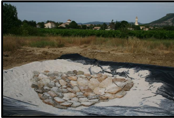
Mise en place du dallage
