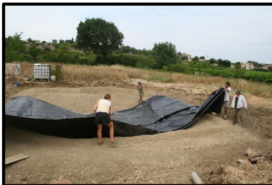
Pose de la bâche
