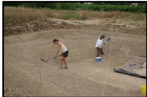
Nivellement manuel et pose de sable
